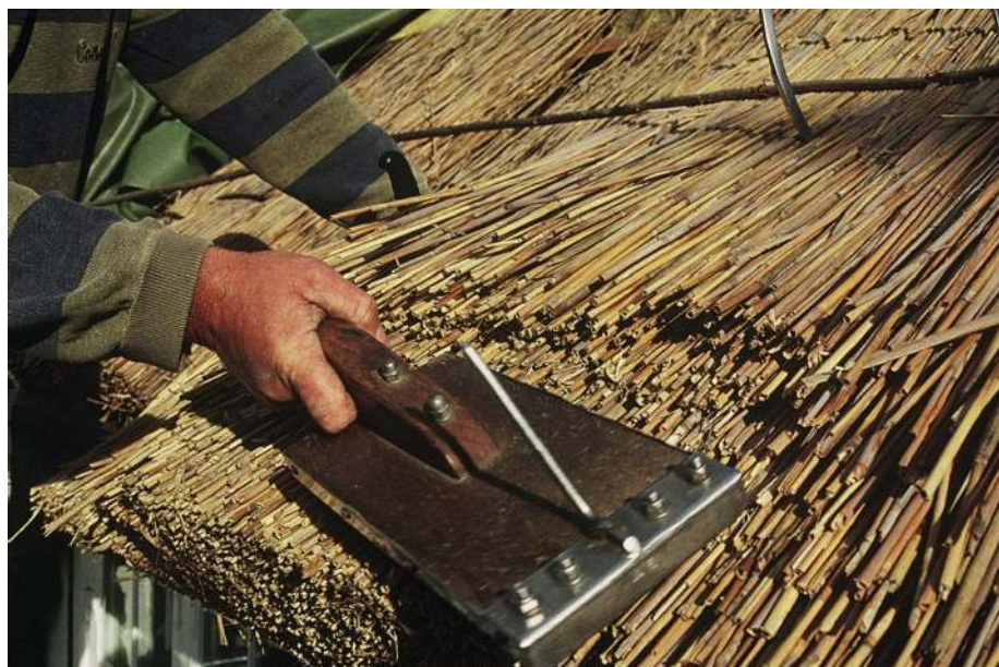
Tækkemanden banker stråtaget ensartet og stramt op med et klapbræt.
