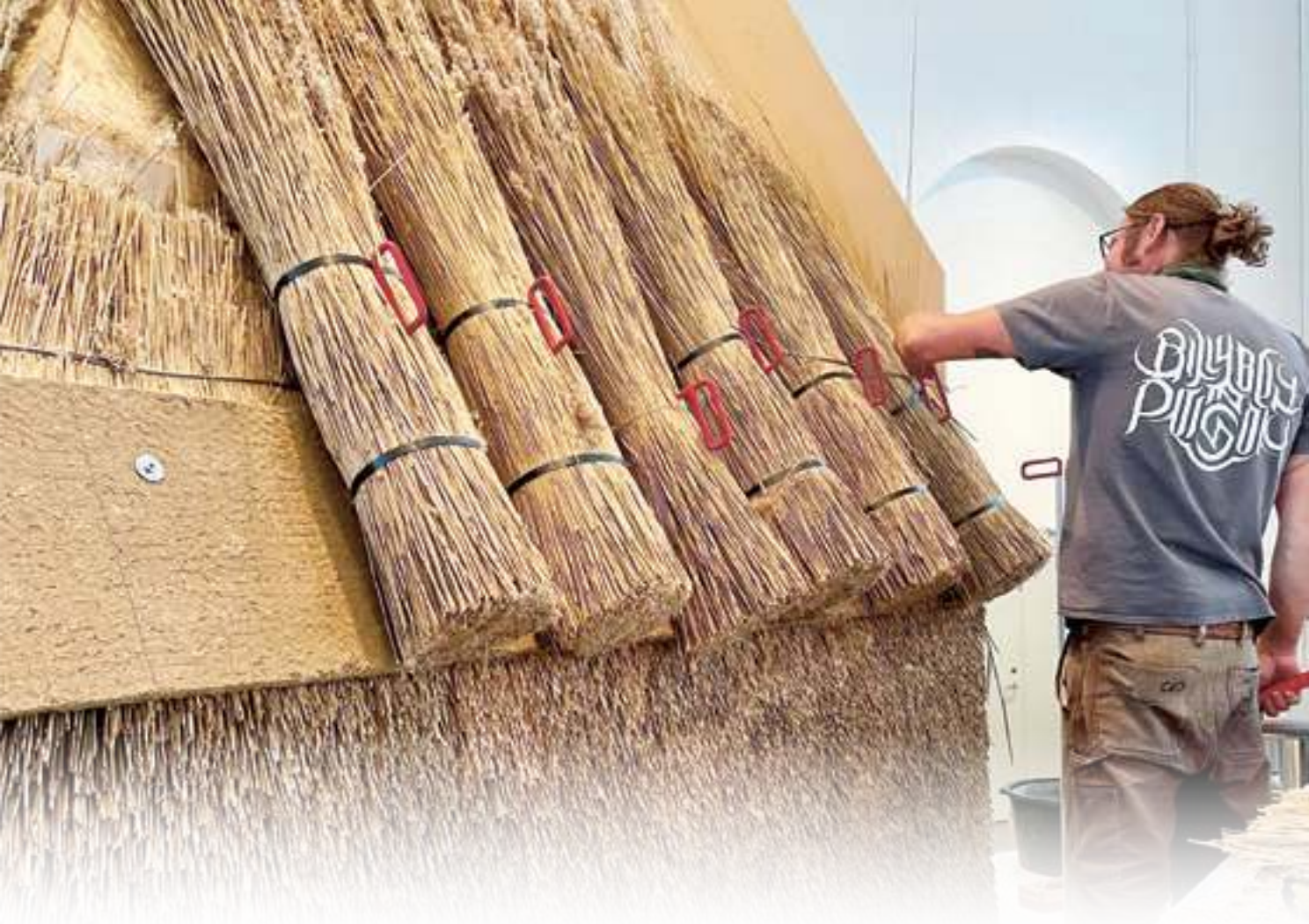
Den tækkede mockup under opførelse - bemærk lerpladerne til venstre i foto.
