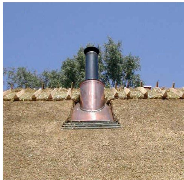
Foto 60 Kobberinddækket stålskorsten
