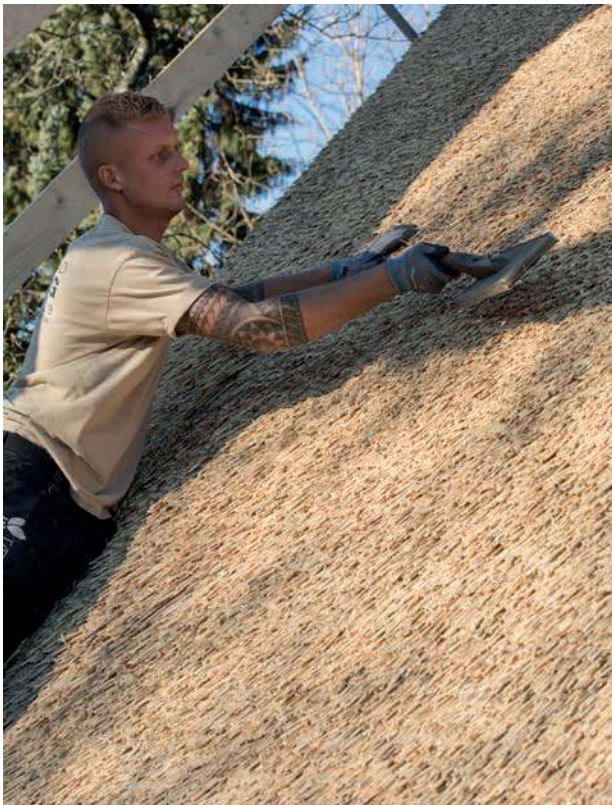
Foto 34 Tagfladen bankes på plads med en tækkeskivl
