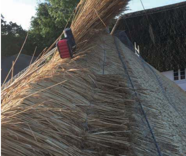
Foto 32 Rygning med overbuk
