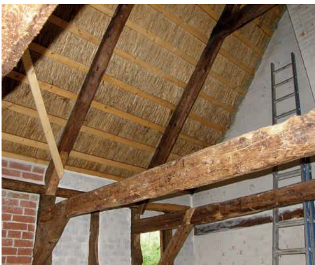
Foto 30 Brolag sikrer en pæn underside
