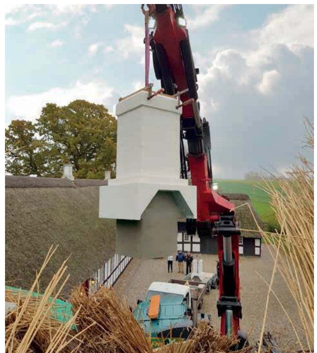
Foto 58 Opsætning af ny skorsten med udkrøgning
