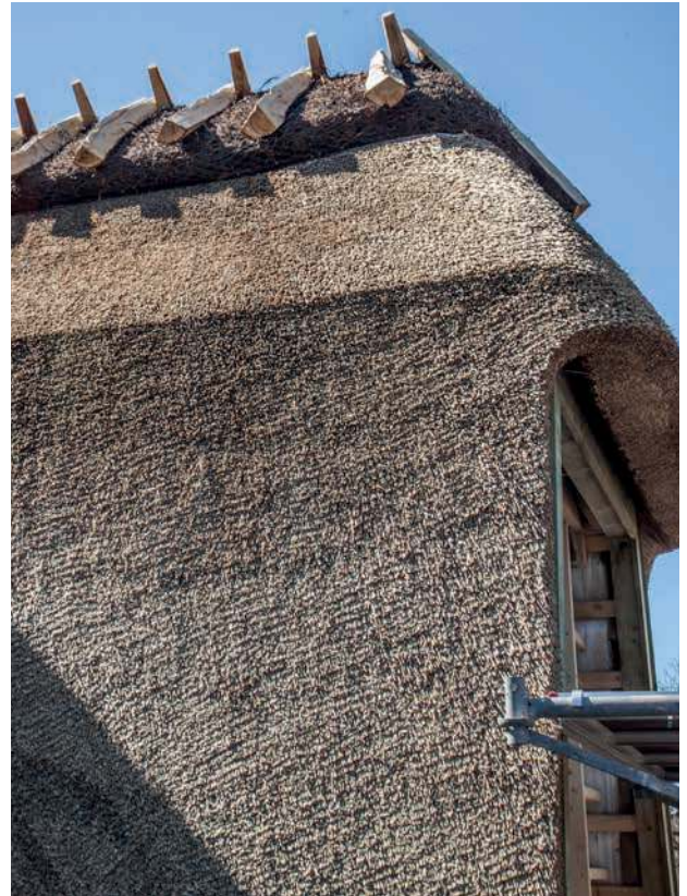
Foto 73 Tækning af mansardtag
