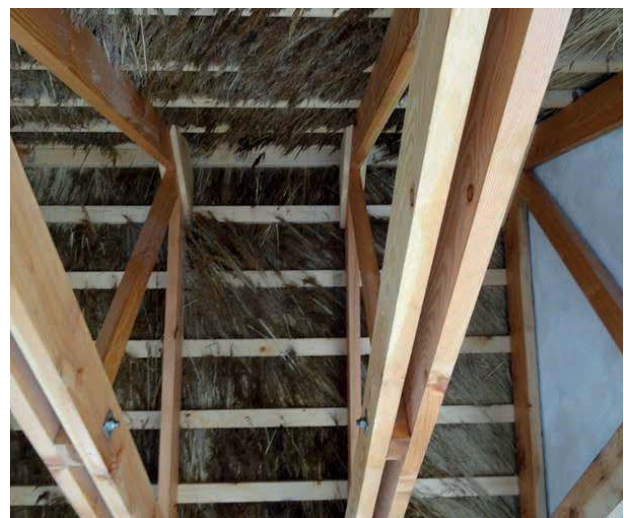
Foto 31 Uden brolag får man en "floffy" underside, der drysler
