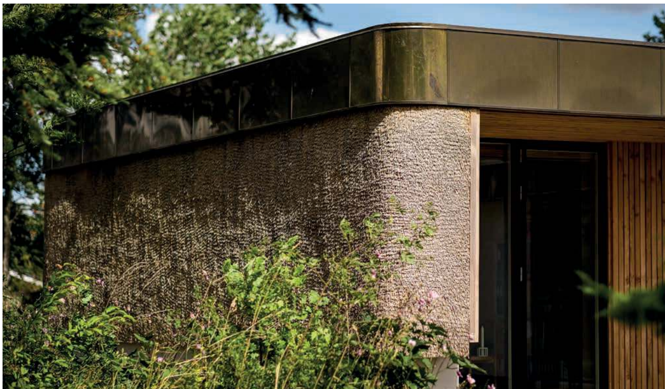
Foto 70 Tækning af lodret facade
