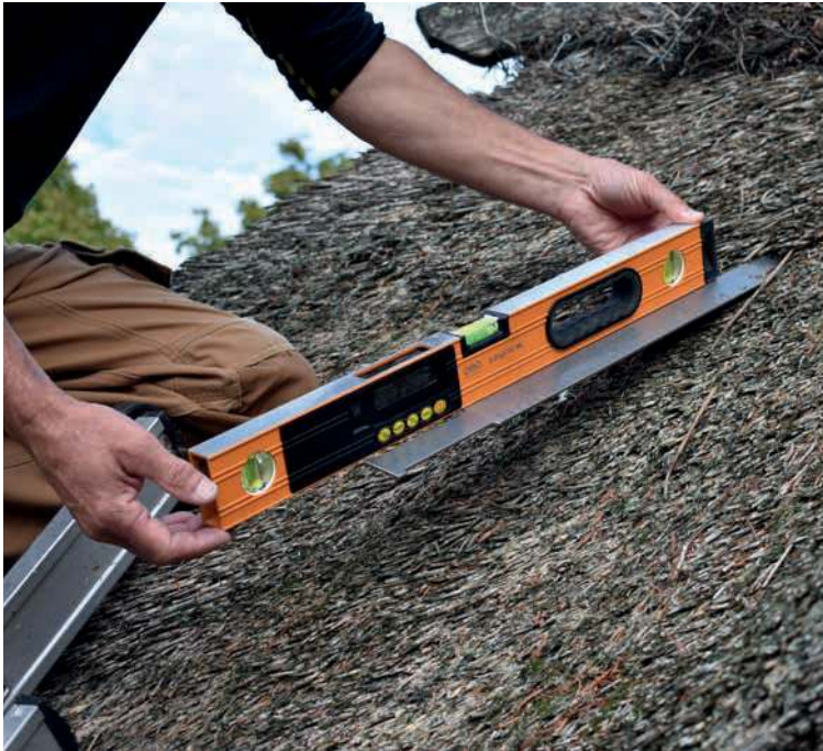
Foto 9 Måling af rørenes hældning
