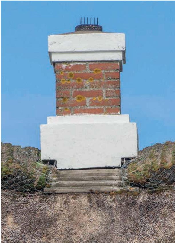
Foto 56 Skorsten med muret udkrøgning
