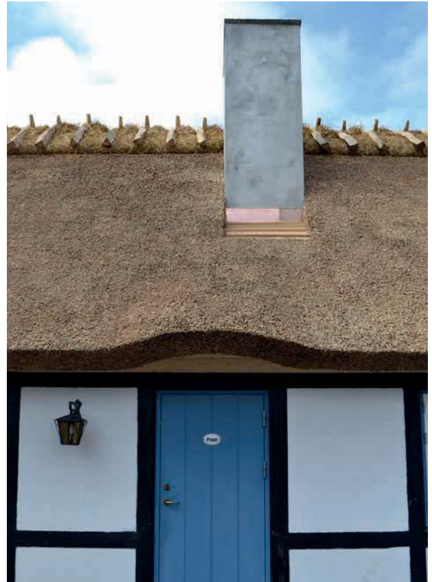
Foto 57 Skorsten med kobberinddækning
