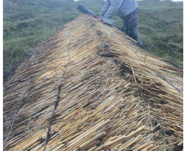
Foto 33 Rygning, der er klippet
