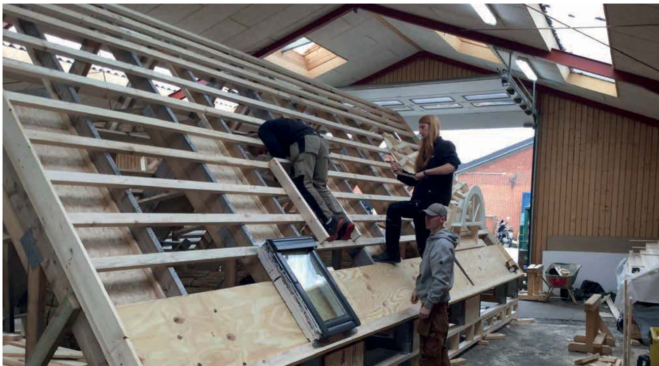
Foto 46 Tagkonstruktion lægtet til stråtag
